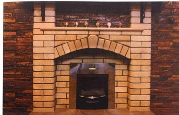
Такая металлическая печь для бани При монтаже металлической печи очень важно изолировать ее толщу от деревянных конструкций. Чаще всего используют простую двойную обшивку: сначала кирпичный портал в виде керамического камня. Простое и недорогое. Картина с кирпичом выводится в парной.
